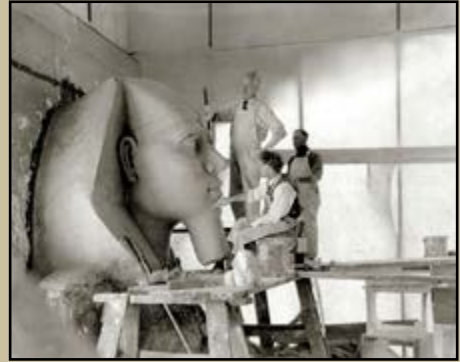
Construction d'un sphinx pour le décor des Dix commandements à Guadalupe.
